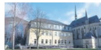
Außenansicht des Schulgebäudes neben der Kirche.
